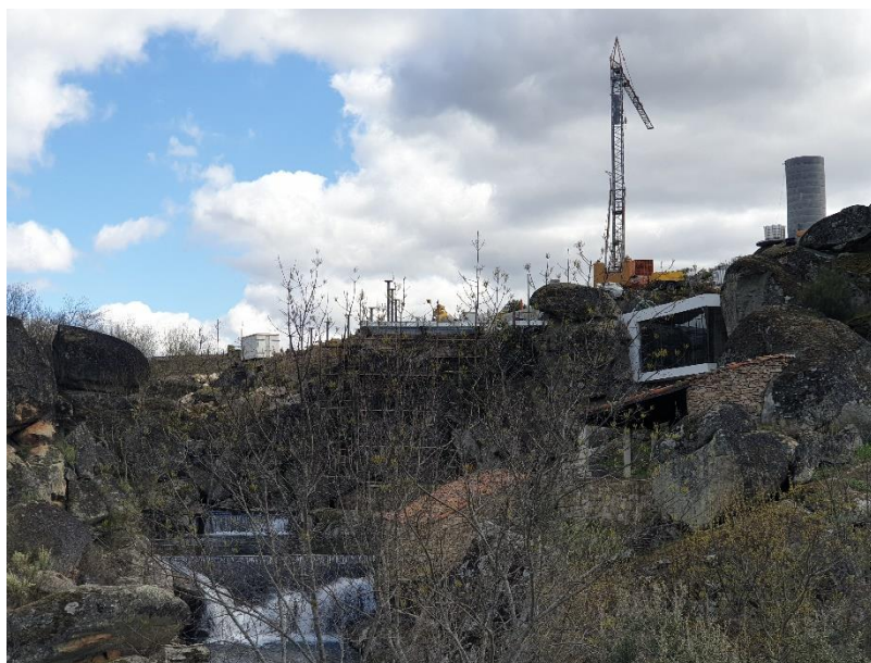
Fotografia 5.36 – Área em construção no interior da área de estudo (Fonte: FUTURE PROMAN março 2021)
